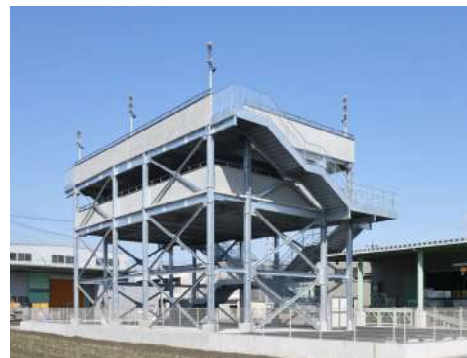
<津波避難施設>
