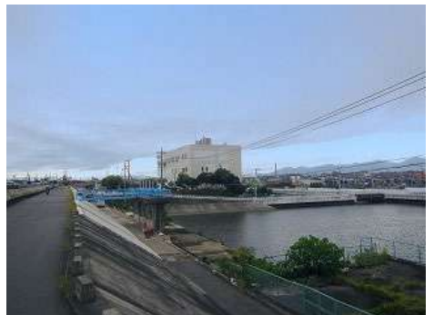
<川越排水機場>
