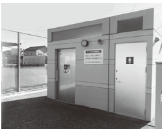
公園にあるトイレ
