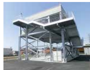
亀須・亀崎地区津波避難タワー
