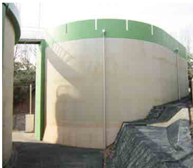
埋縄第2配水タンク タンク容量1,500m 3
