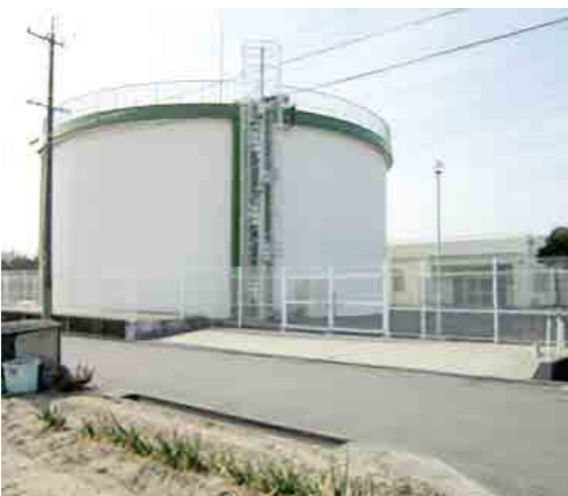
朝明配水場 タンク容量2,000m 3
