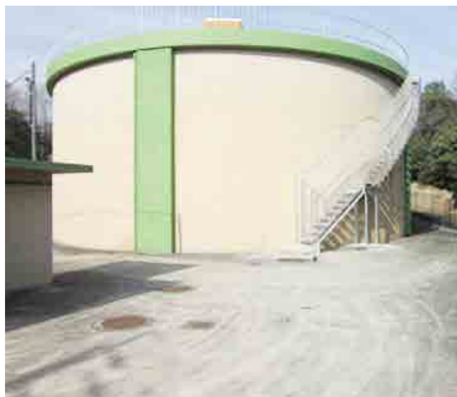
埋縄第1配水タンク タンク容量2,500m 3
