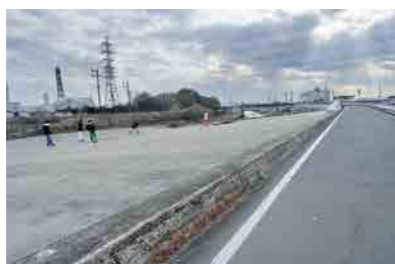
北部浄化センター西側の堤防道路
