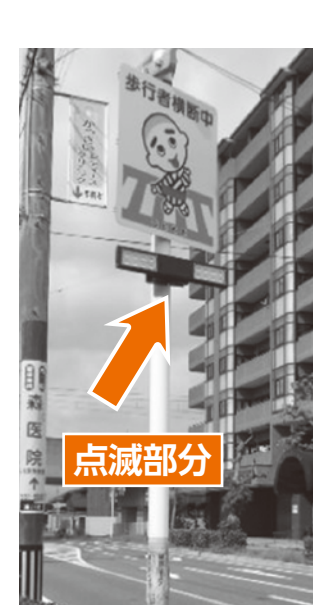
点滅照明付き看板の設置例
