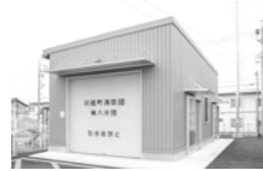
亀須消防車庫
